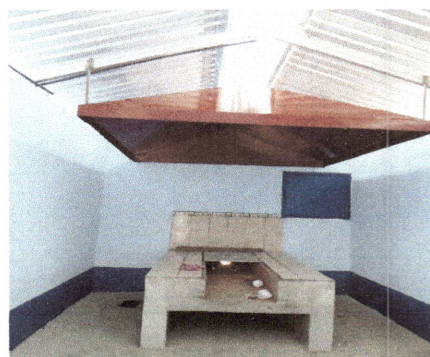
Foto 2: Instalación nueva de estructura de techo y cubierta de lámina de cocina, estufa rural sustituida e instalación de campana tipo chimenea.
