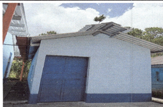
Foto 4: Puerta de cocina sustituida, estructura de techo y cubierta de lámina instalada y paredes ya remozadas.
