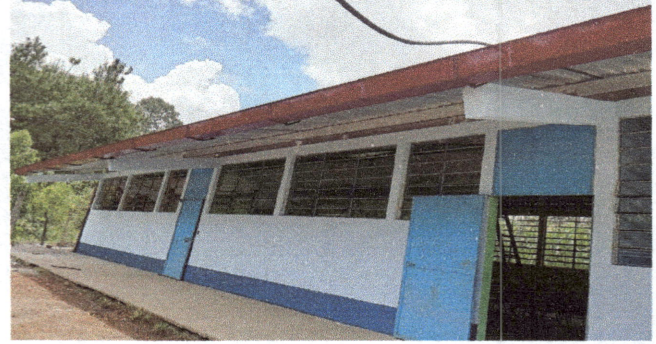
Foto 8: Pintura exterior ya mejorada.
