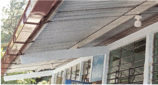
Foto 7: Canales de agua instalados y vidrios de ventanas sustituidos.
