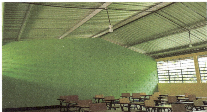
Foto 1: Estructura de techo y cubierta de lamina ya instalada, y pintura interior sustituida en Módulo 1.
