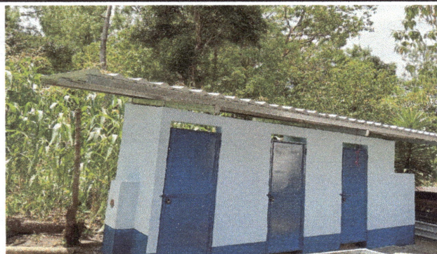
Foto 3: Estructura de techo, cubierta de lámina, puertas nuevas instaladas y pintura sustituida en baños.
