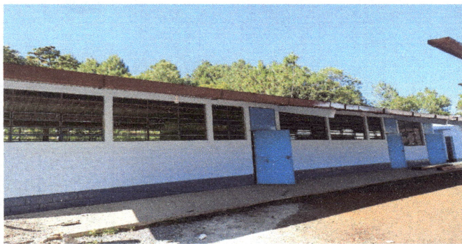
Foto 9: estructura de techo y cubierta de lámina ya instalados en módulo 1.
